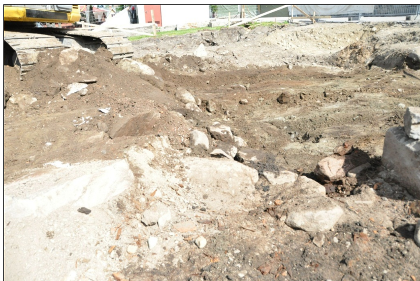
Kuva 5. Kaivinkoneen edessä näkyvissä heti alueen 1 länsipuolelta esille tullutta styroksia, joka osoittaa paikalla olleen lämmitysöljyputken kaivannon sijainnin. Kaivausalue 1 oikealla.
