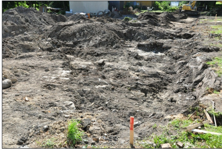
Kuva 20. Valvottuna kaivettu alue. Idästä.
