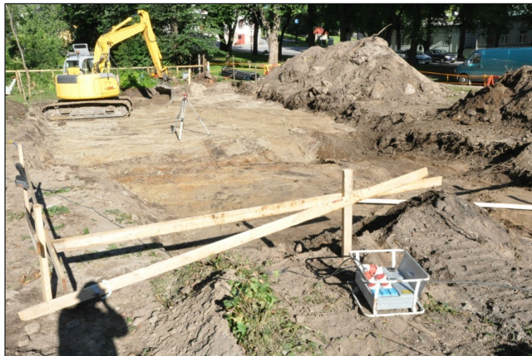
Kuva 22. Valvottuna kaivettun alueen länsipäätä; sekoittuneen (pelto-?) kerroksen alta paljastunutta puhdasta hiekkaa. Kaakosta.
